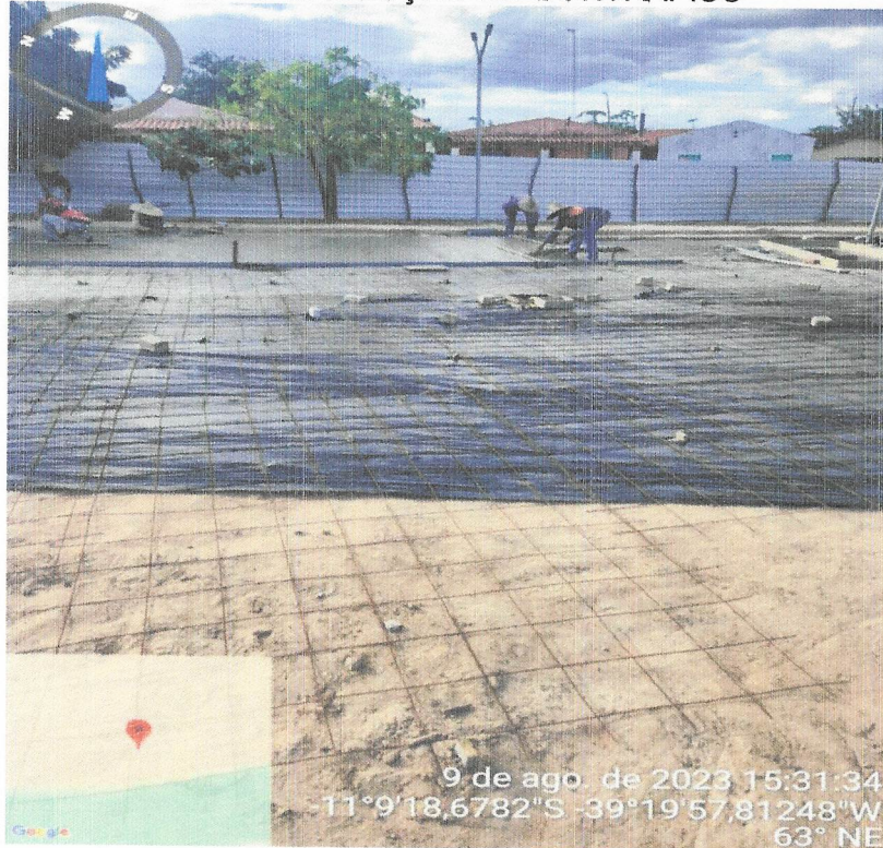
Foto 15- EXECUÇÃO DO CONTRAPISO
