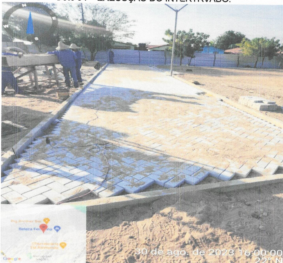
Foto 04 – EXECUÇÃO DO INTERTRAVADO.
