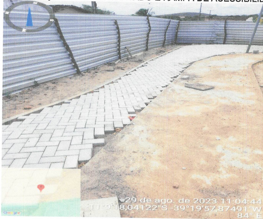
Foto 8: EXECUÇÃO DO INTETRAVADO
