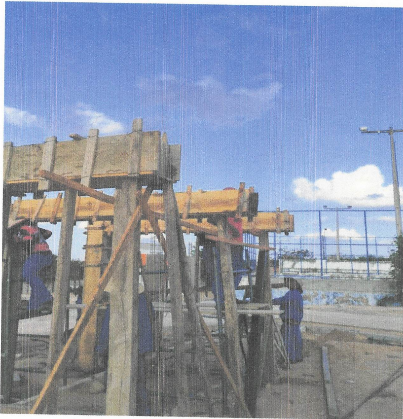
Foto 41- EXECUÇÃO DA VIGA DO PERGOLADO
