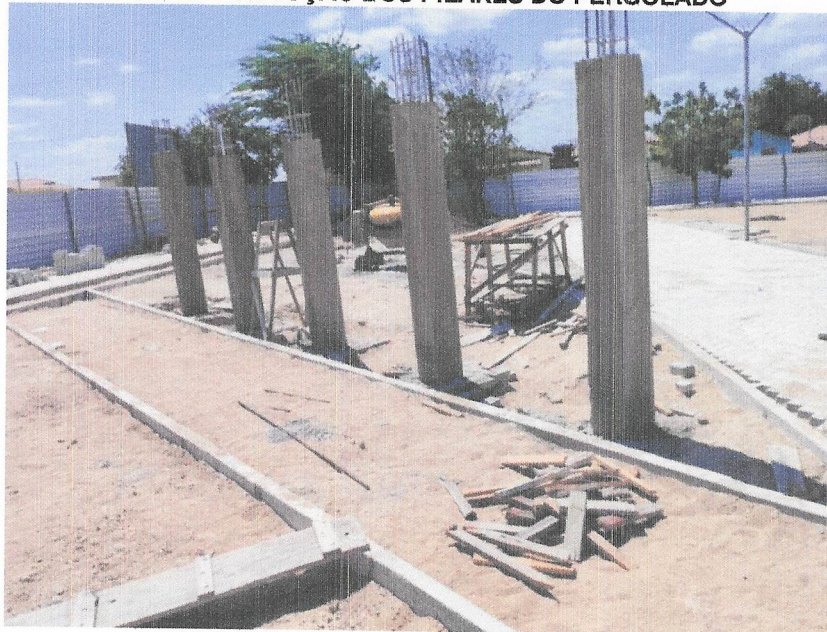
Foto 39- EXECUÇÃO DOS PILARES DO PERGOLADO
