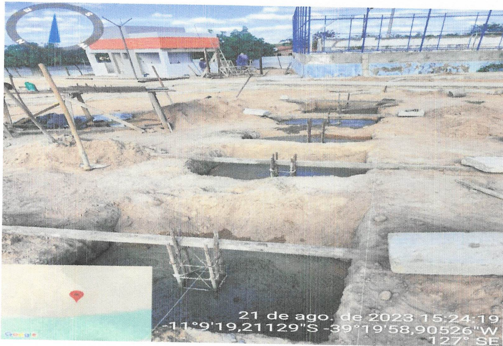
Foto 37- EXECUÇÃO DOS PILARES DO PERGOLADO
