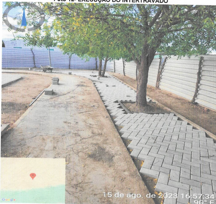
Foto 12- EXECUÇÃO DO INTERTRAVADO
