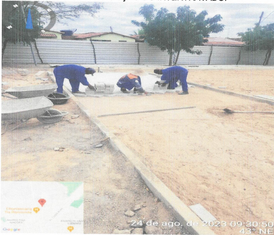
Foto 04 – EXECUÇÃO DO INTERTRAVADO.
