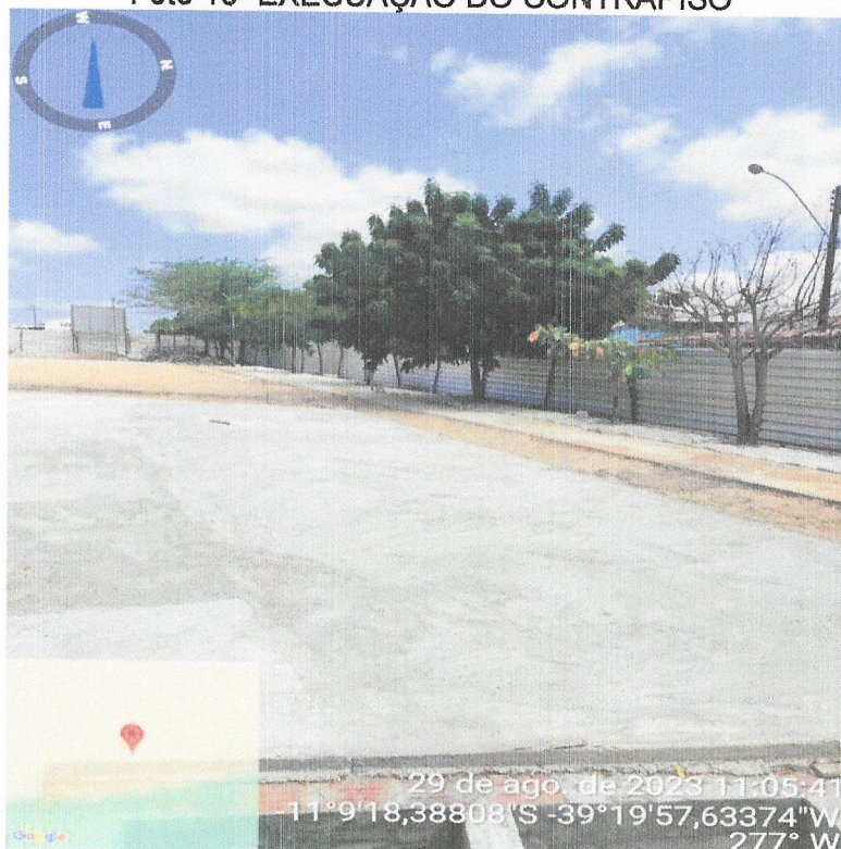
Foto 16- EXECUÇÃO DO CONTRAPISO
