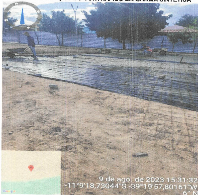
Foto 14- EXECUÇÃO DO CONTRAPISO DA GRAMA SINTÉTICA
