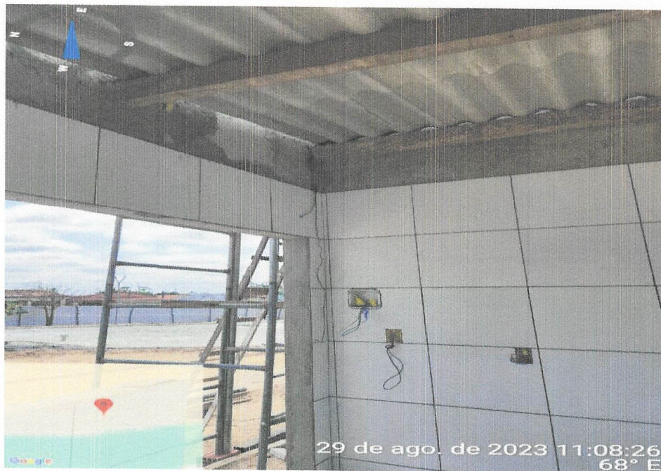
Foto 31- EXECUÇÃO DO REVESTIMENTO INSTALAÇÕES ELÉTRICAS
