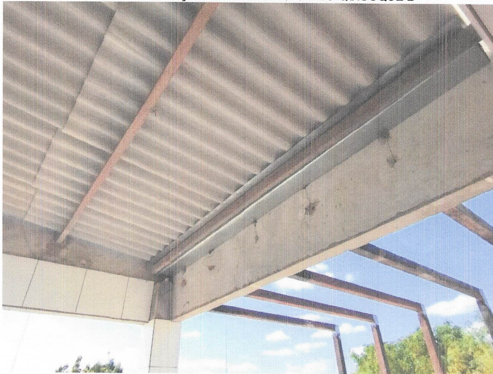
Foto 10- EXECUÇÃO DA CALHA DE ZINCO QUIOSQUE 2
