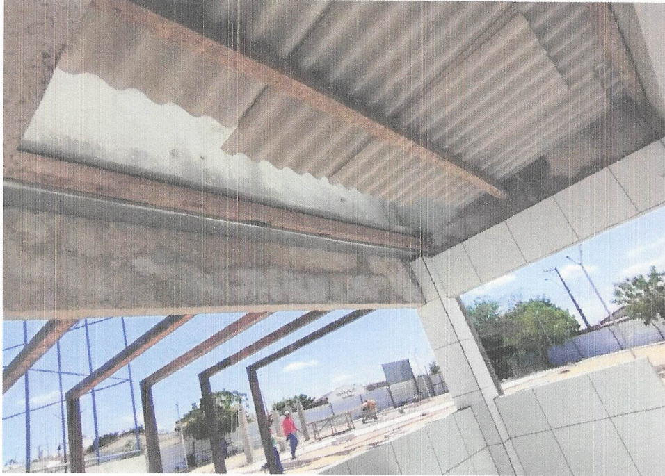
Foto 10- EXECUÇÃO DA CALHA DE ZINCO QUIOSQUE 2
