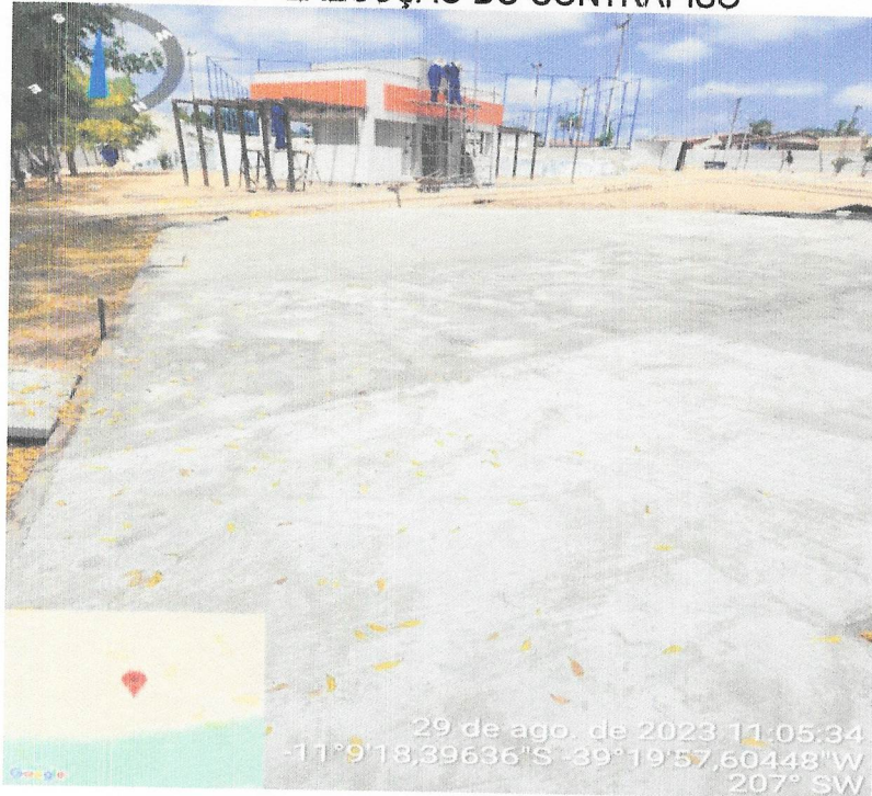
Foto 17- EXECUÇÃO DO CONTRAPISO
