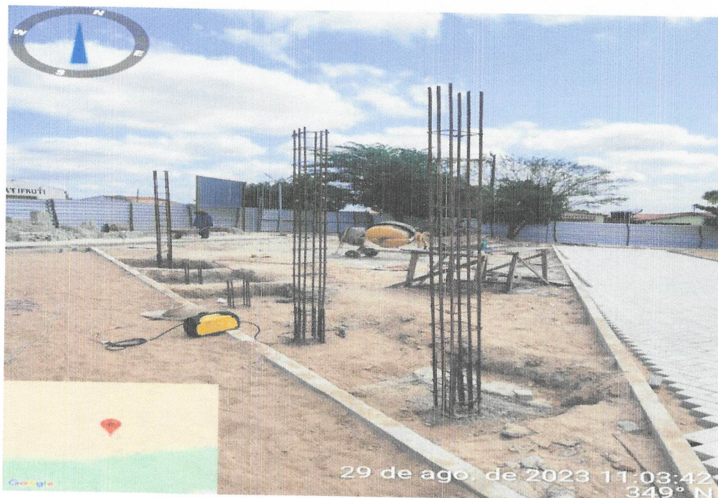
Foto 37- EXECUÇÃO DOS PILARES DO PERGOLADO
