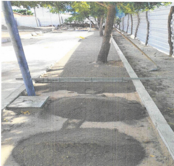
Foto 02 – EXECUÇÃO DO INTERTRAVADO.
