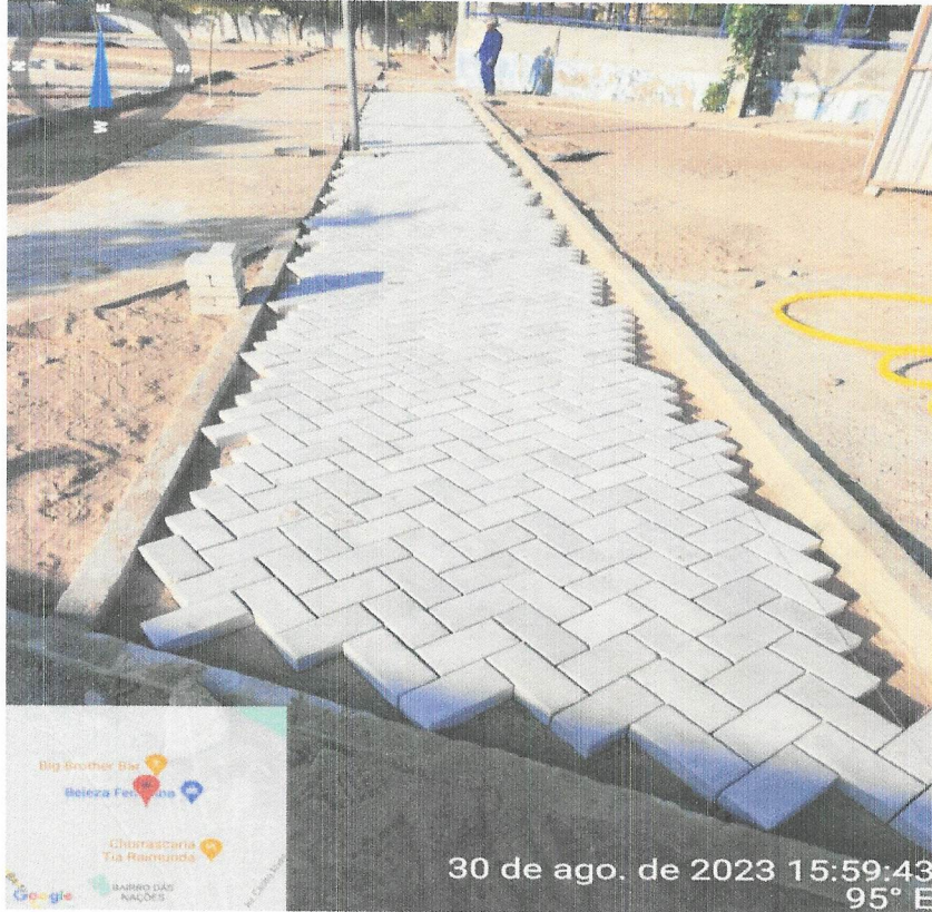
Foto 6: EXECUÇÃO DE INTERTRAVADO
