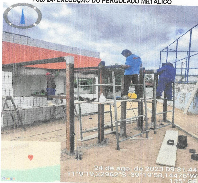
Foto 24- EXECUÇÃO DO PERGOLADO MÉTÁLICO
