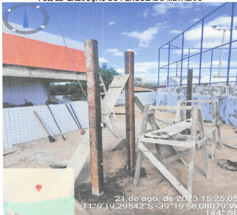
Foto 22- EXECUÇÃO DO PERGOLADO MÉTÁLICO
