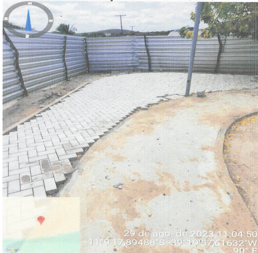
Foto 6: EXECUÇÃO DE INTERTRAVADO
