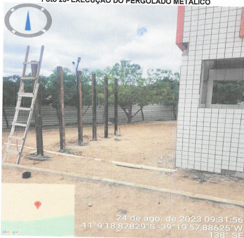
Foto 23- EXECUÇÃO DO PERGOLADO MÉTÁLICO
