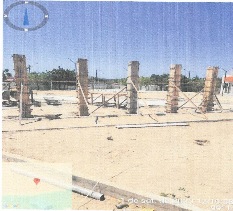
Foto 39- EXECUÇÃO DOS PILARES DO PERGOLADO
