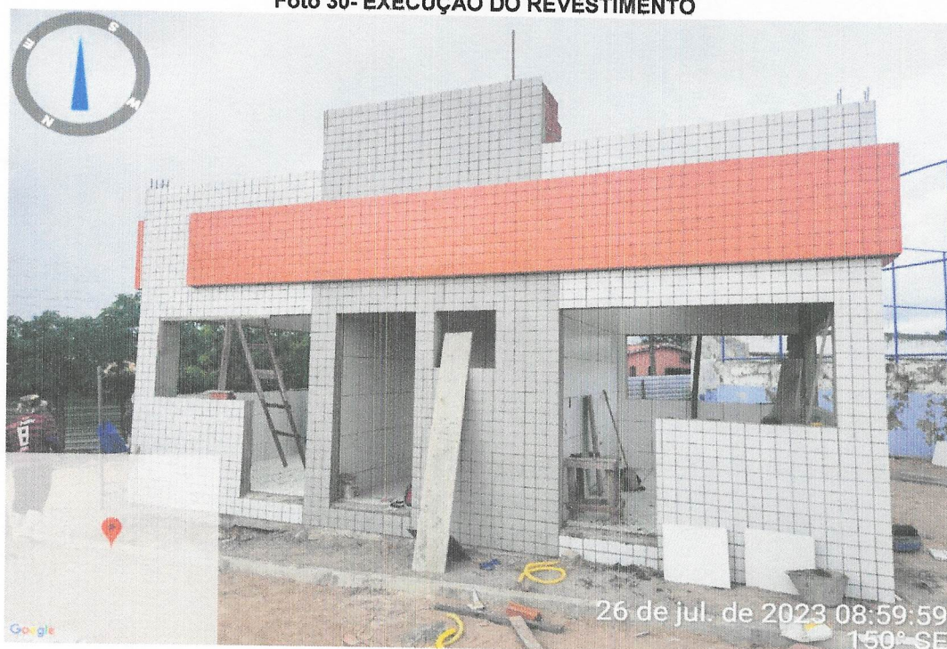
Foto 30- EXECUÇÃO DO REVESTIMENTO
