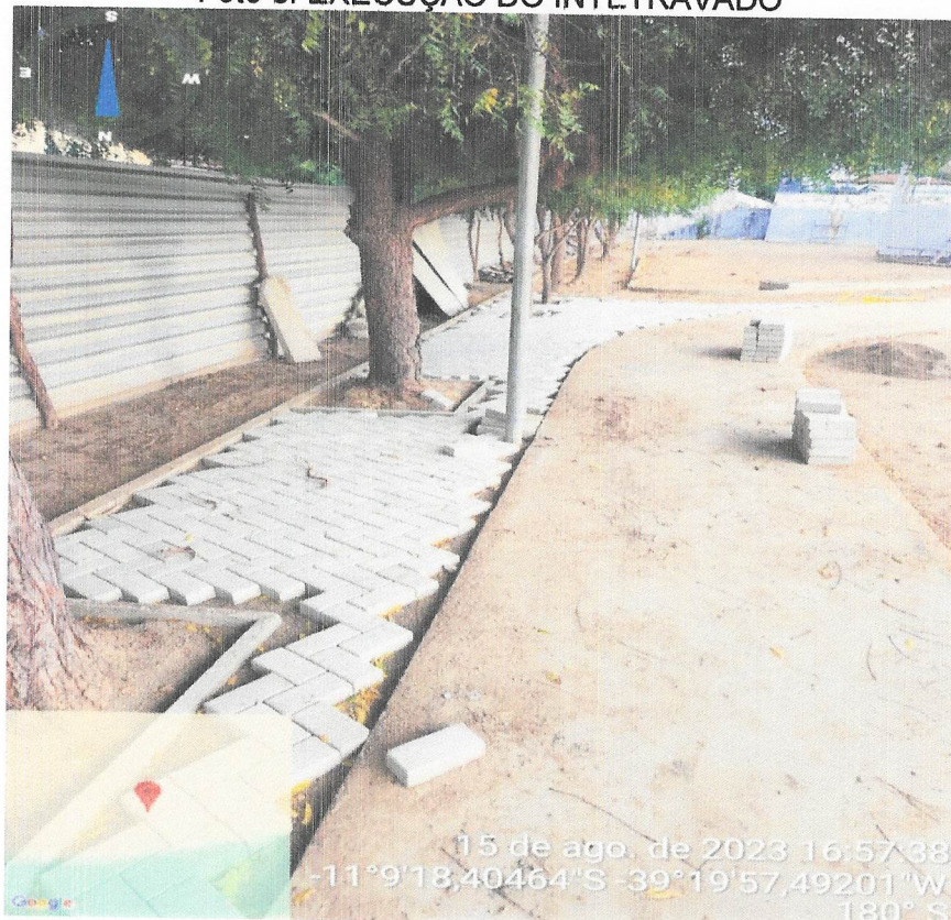
Foto 8: EXECUÇÃO DO INTETRAVADO
