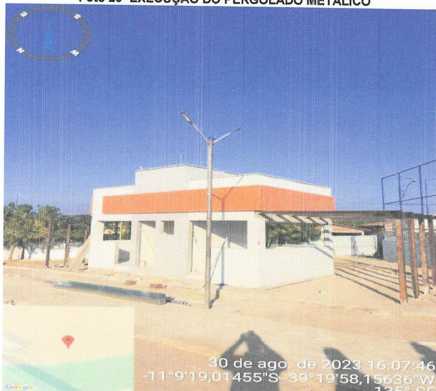
Foto 26- EXECUÇÃO DO PERGOLADO MÉTÁLICO
