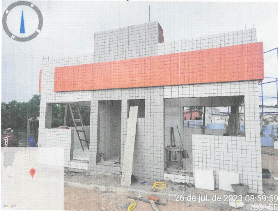
Foto 31- EXECUÇÃO DO REVESTIMENTO
